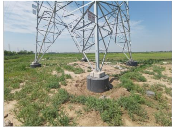
塔基周围生态恢复情况
