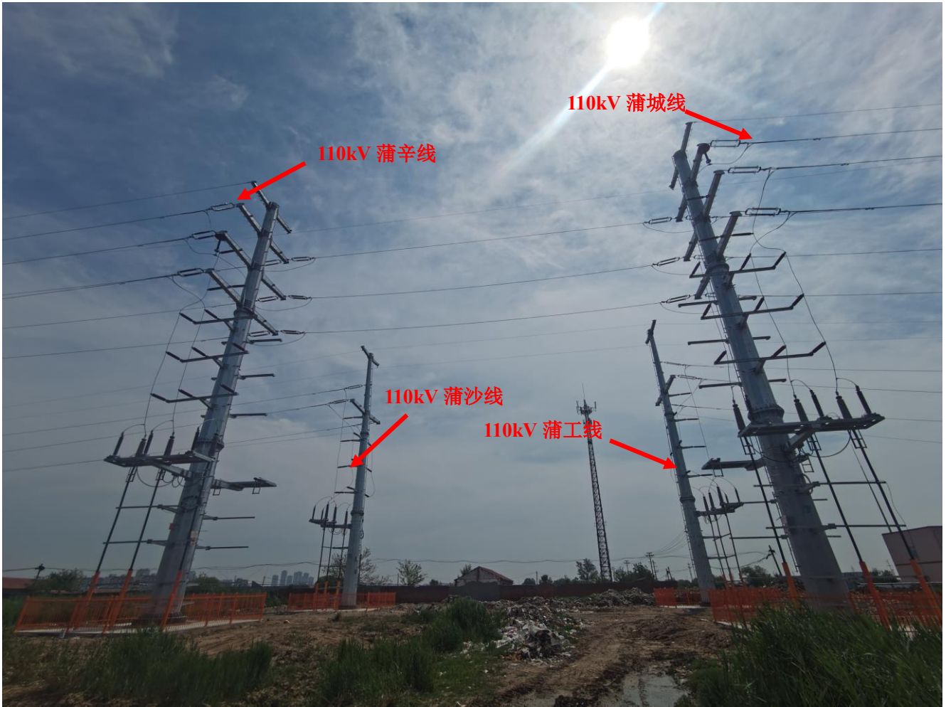
图 4-4 输电线路 \pi 接现场照片
