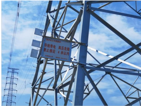
“导线带电 高压危险 禁止靠近 4米以内”警示牌
