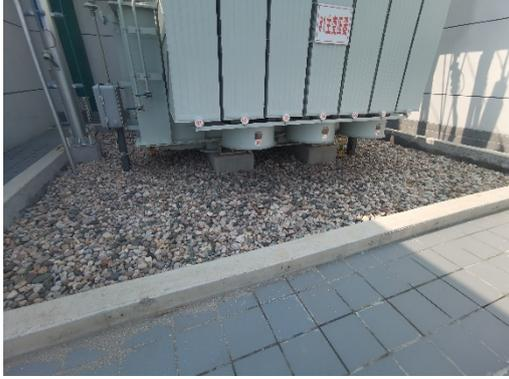
图6-1 主变下方贮油坑
