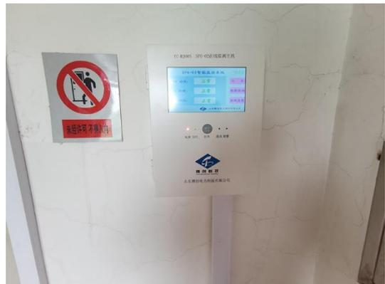
110kV GIS 室内 SF<sub>6</sub>报警装置
