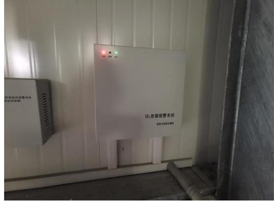
220kV GIS 室内 SF<sub>6</sub>报警装置
