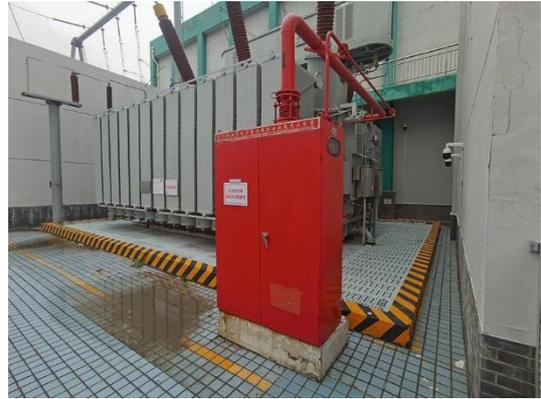
主变配置注氮灭火装置及下方贮油坑
