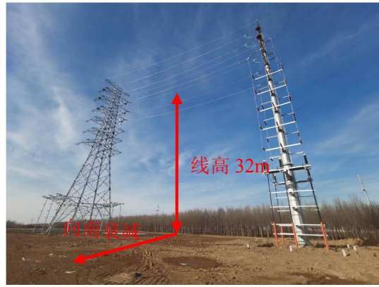
图 7-2 110kV 蒲泉线、110kV 蒲尧线双回架空输电线路衰减
