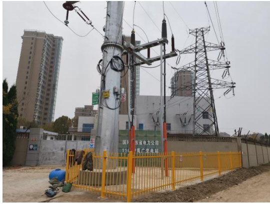
图6-1 新建塔基周围恢复情况
